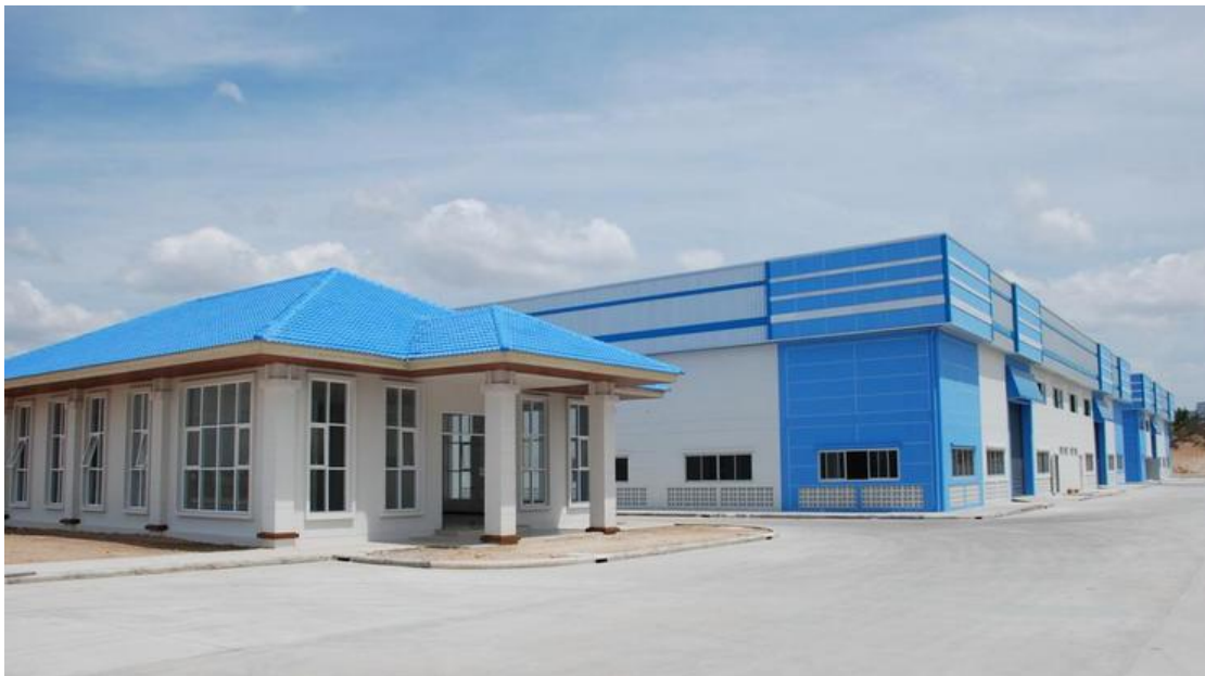
山东省逆变焊机生产项目
