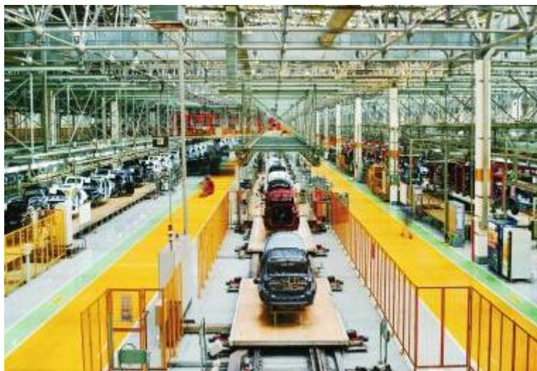
山东省某汽油机扩产改造项目
