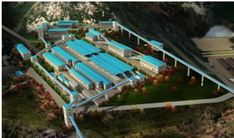
内蒙某铁矿采选工程项目
