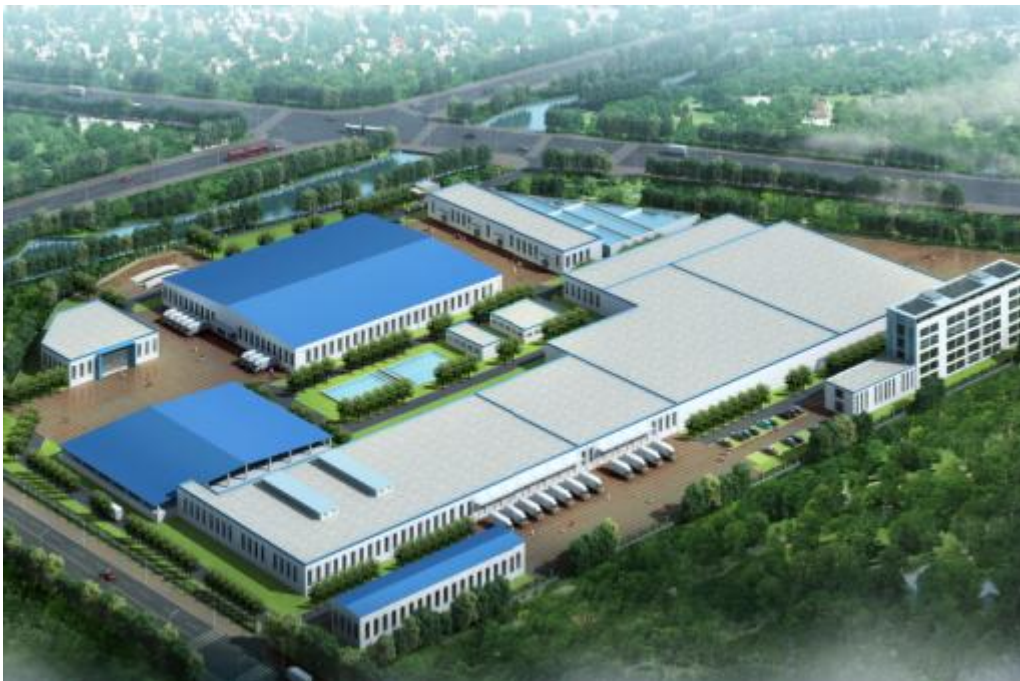
湖北省某公司炉微细粉尘减排装备及配套装置产业化项目
