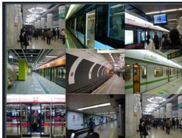
天津某轨道交通监控系统项目
