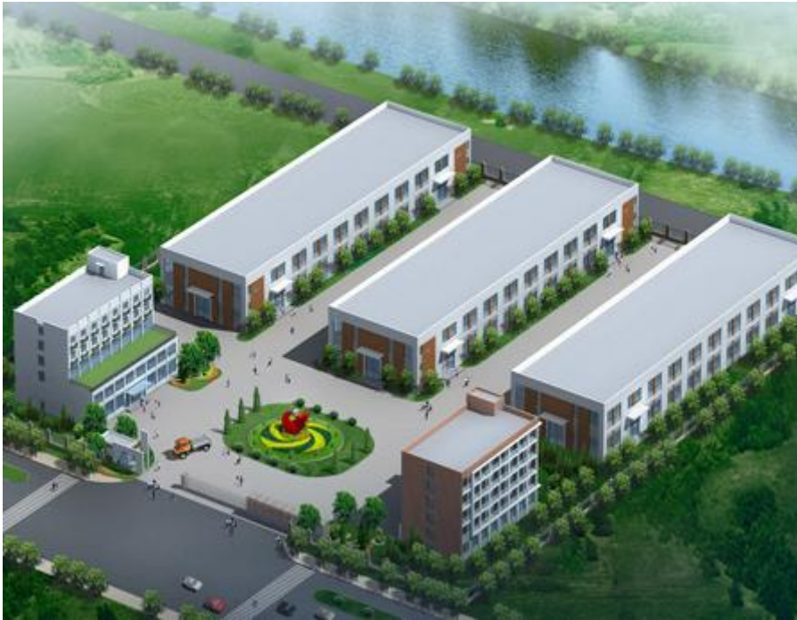
广东省某公司包装设备建设项目
