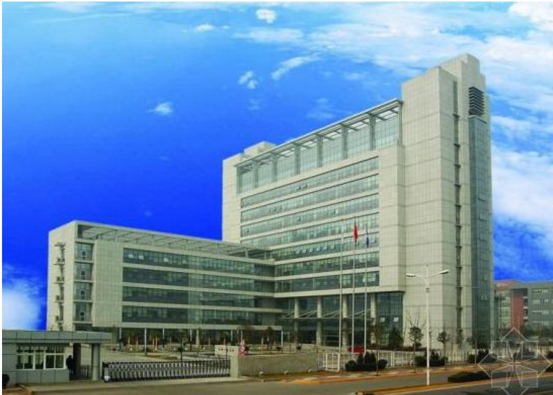
福建省某公司设备状态检测、监测产品生产改造项目
