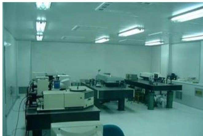
江苏省某光通信技术研发中心建设项目
