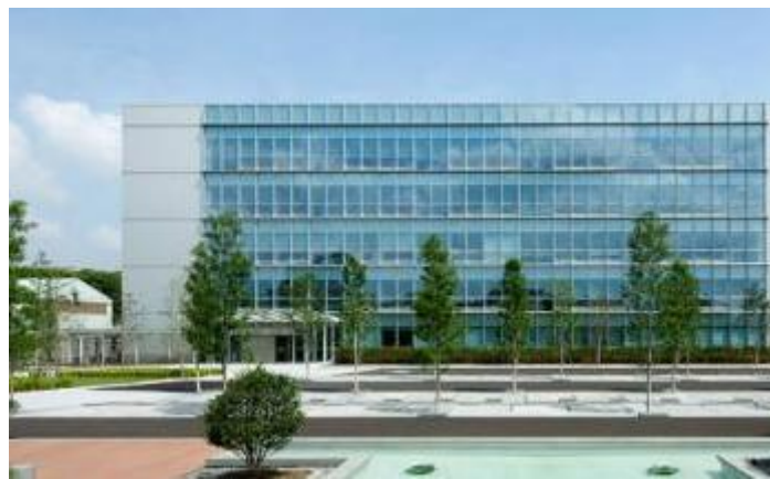
湖北某技术中心建设项目
