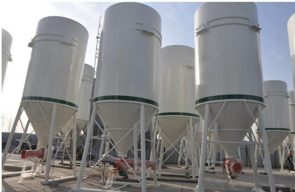
河北某年产 50 万吨干混砂浆项目
