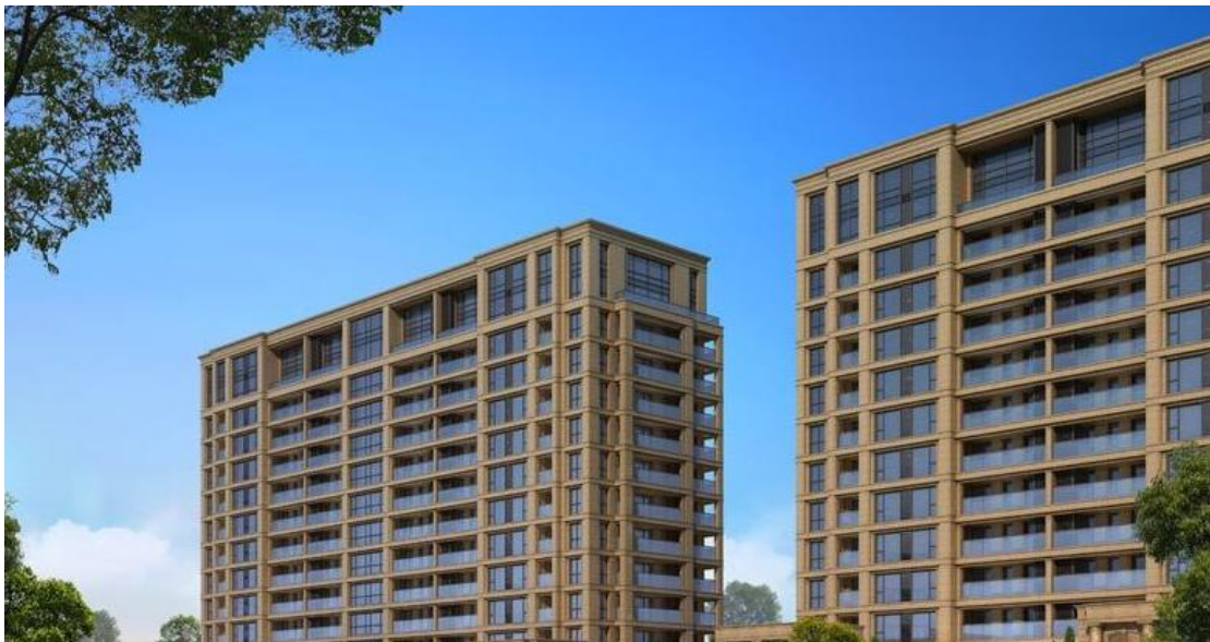
河南省某老年住宅公寓建设项目
