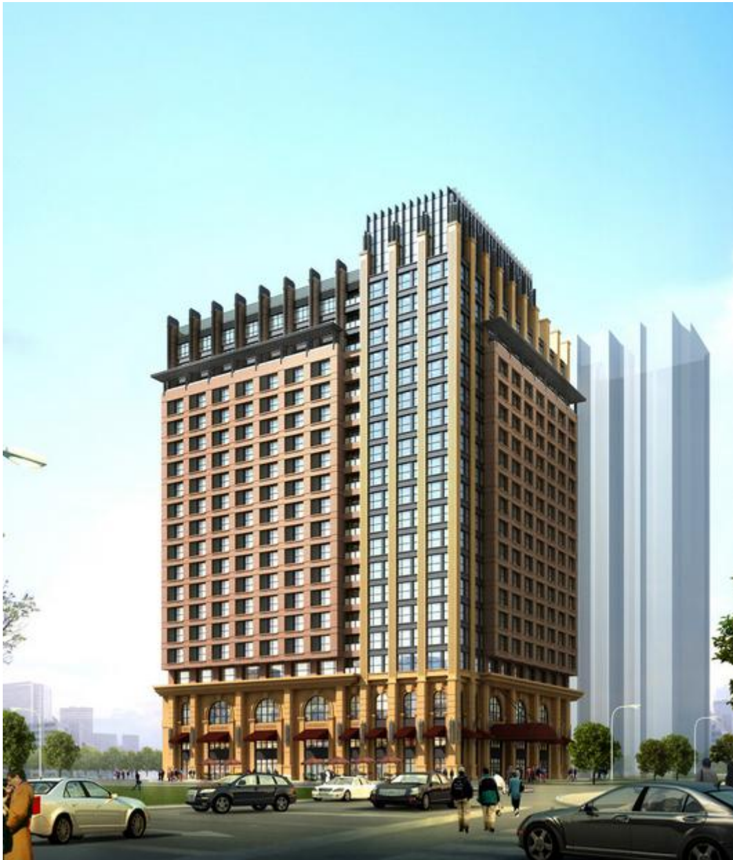
河南省某老年住宅公寓建设项目
