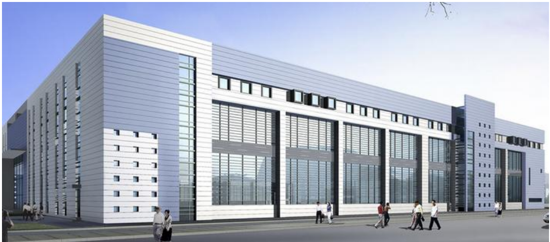
河北某能源动力电池建设项目
