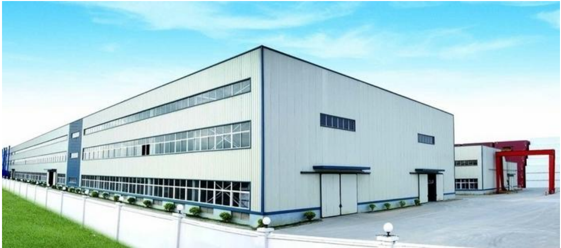
山东年产 4000 吨亚氯酸钠项目
