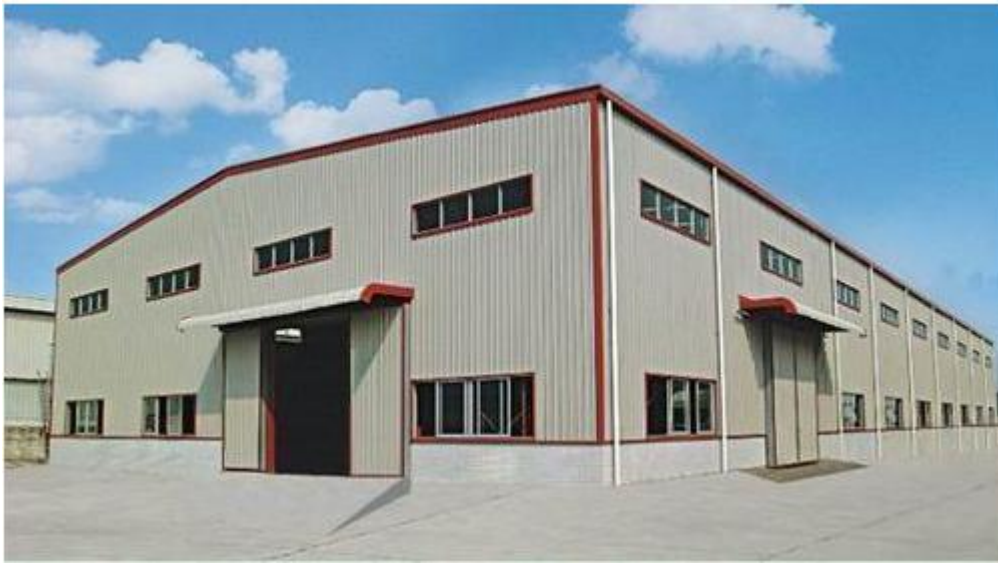
河北某标准厂房建设项目
