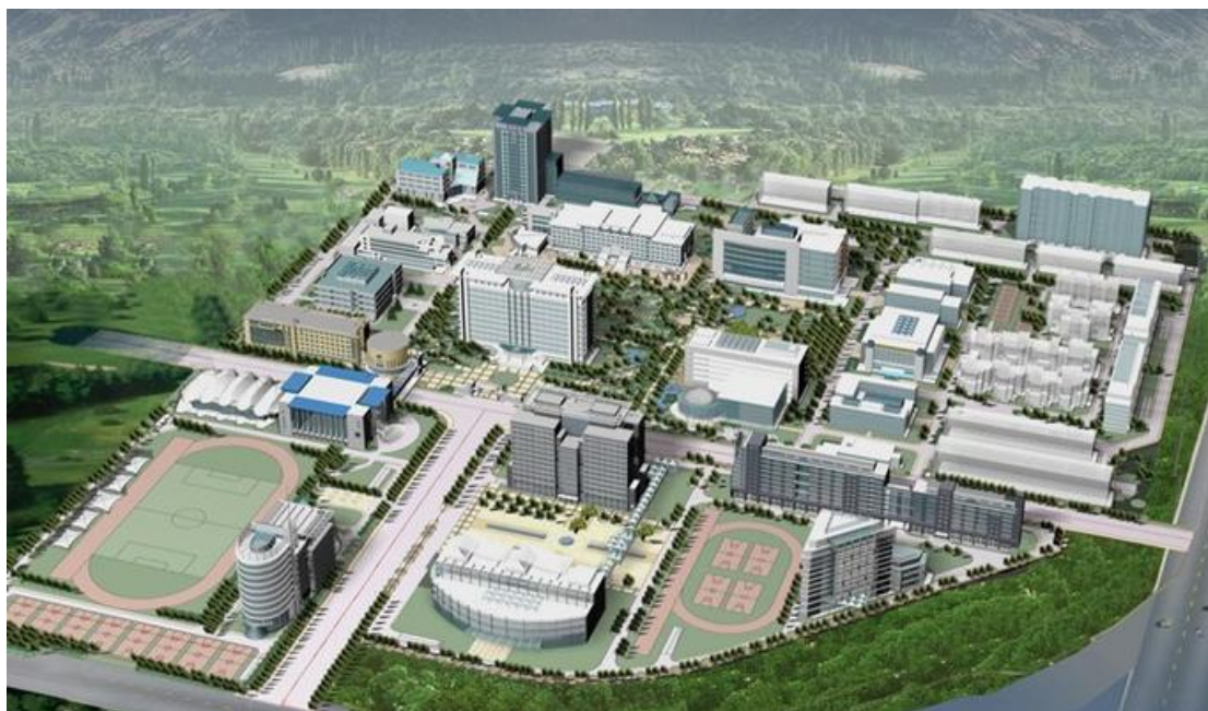
浙江省某高职院校新校区建设项目
