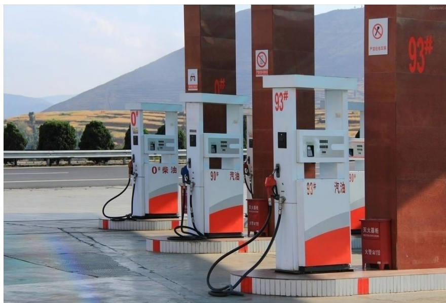
辽宁省某加油站建设项目
