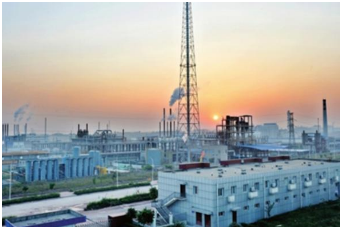
湖北省某公司年产 1 万吨金属镁项目
