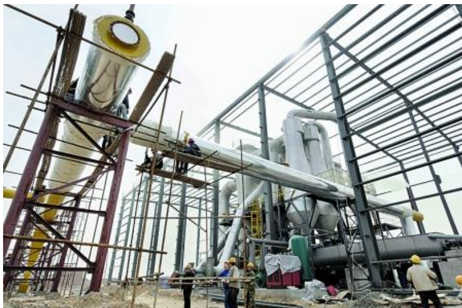
内蒙古某电石渣综合利用水泥生产线项目
