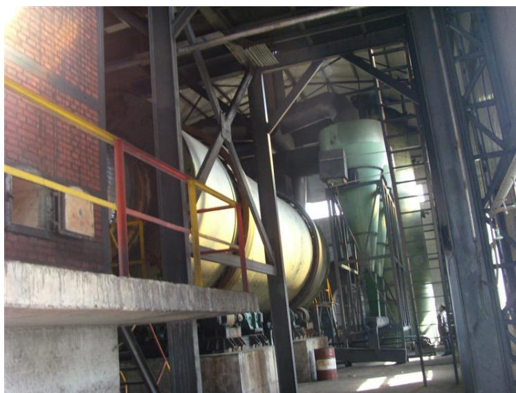
河北省某水泥生产线项目
