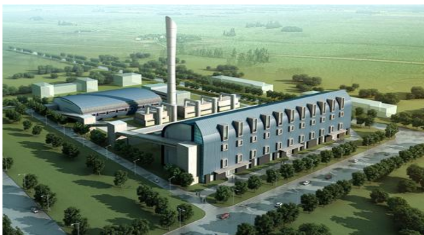
西藏自治区某县城供暖项目
