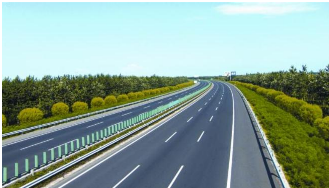
图表 2：吉林省某段高速公路项目
