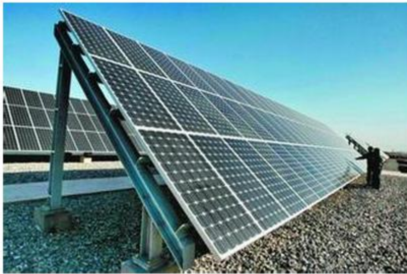
山东某公司年产 200 吨电子级多晶硅项目
