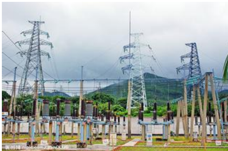
黑龙江省某 220kV 变电站综合自动化改造项目
