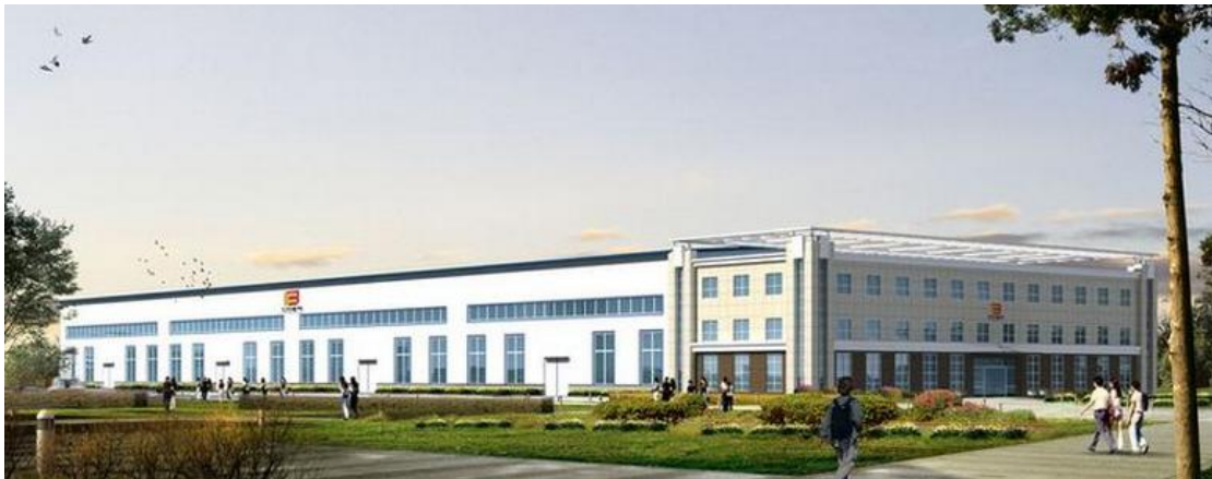
广东省某公司汽车零部件生产项目
