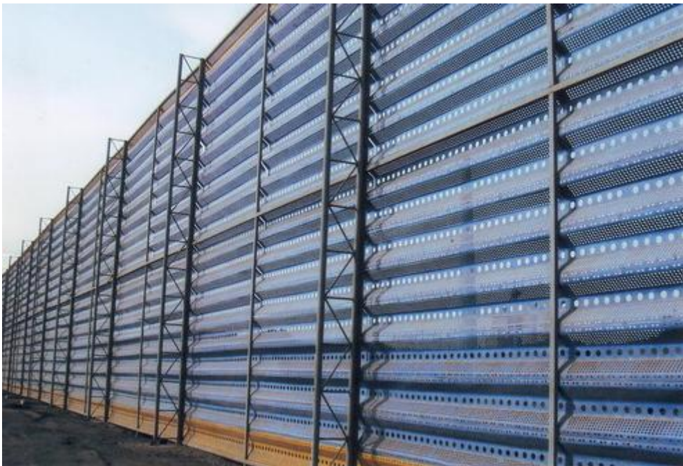
天津煤场防风抑尘网工程项目
