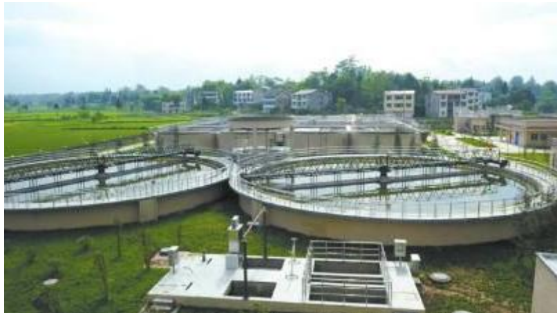
浙江省某污水处理工程项目
