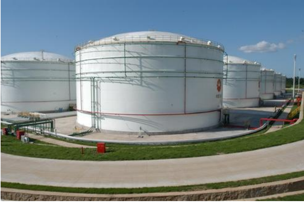
某石油集团成都成品油库建设项目
