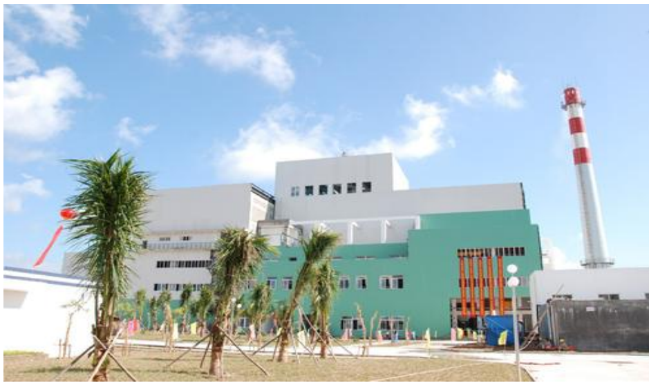
湖北省城市生活垃圾焚烧发电项目
