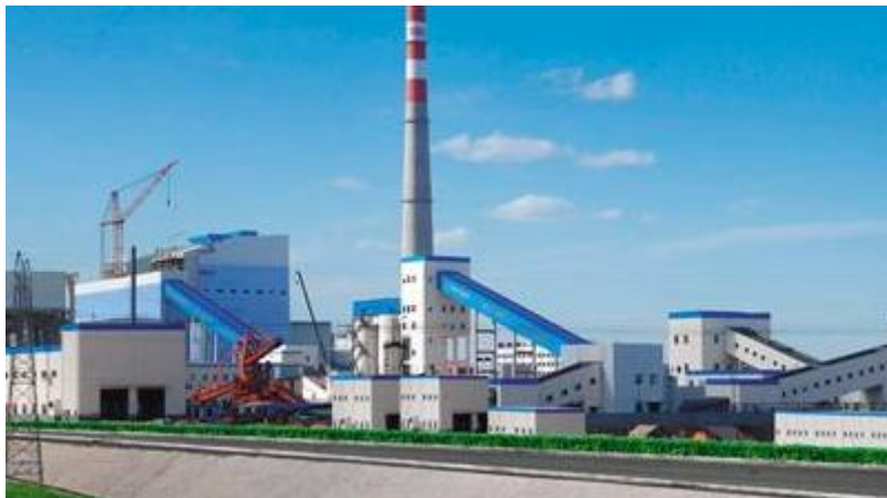
深圳某公司煤矸石发电项目
