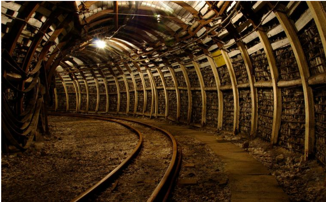
河南省某煤矿项目
