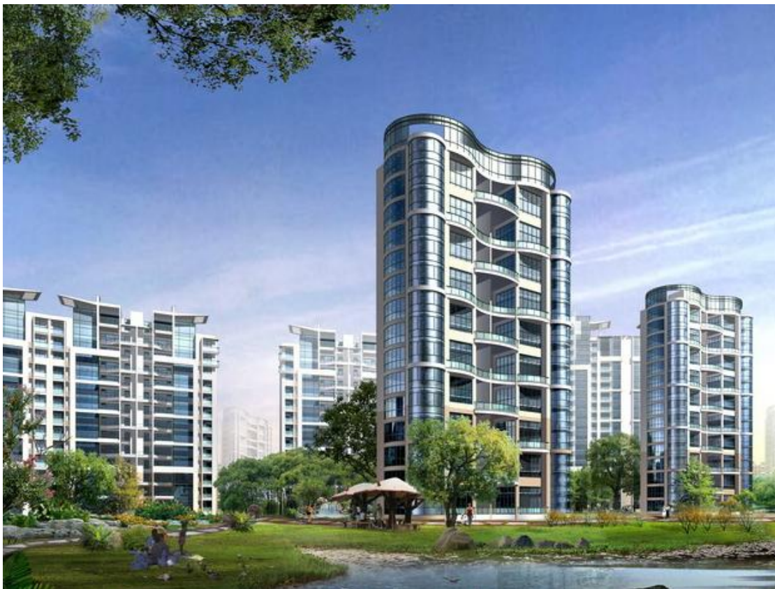
山东某居民小区住宅建设项目
