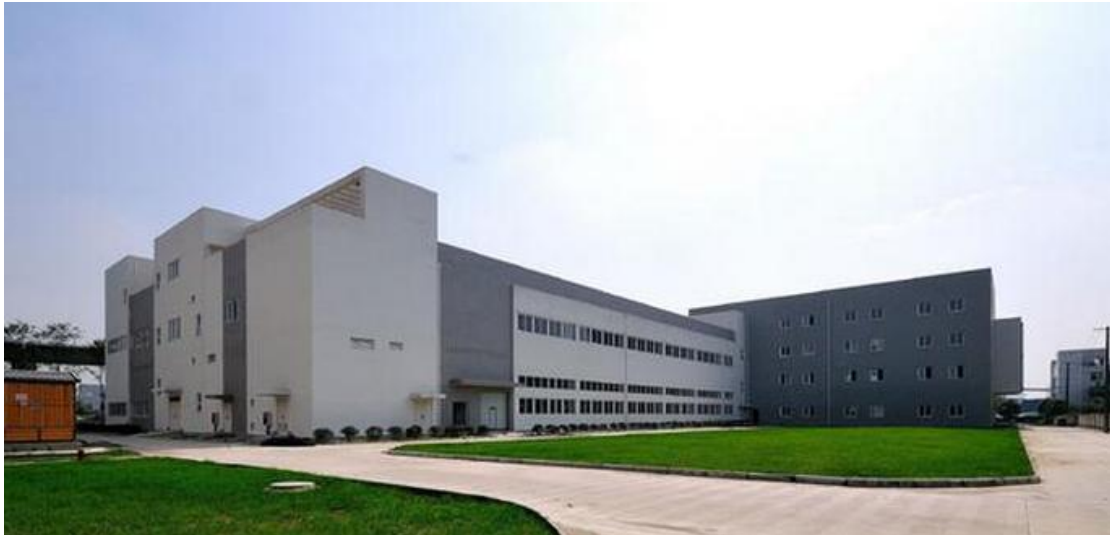
山东省某公司超滤膜项目
