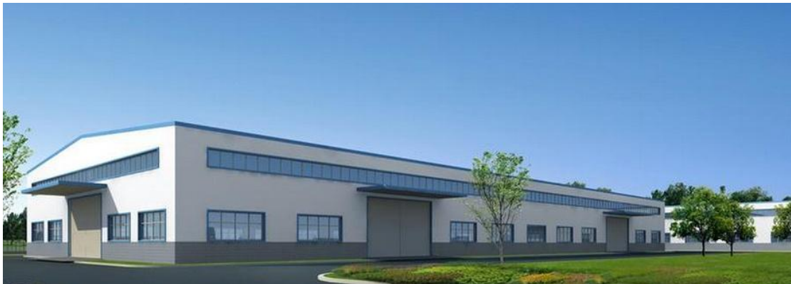
安徽省某公司保温材料项目
