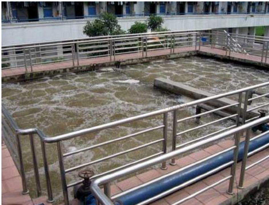
陕西省某开发区城市污水处理工程项目
