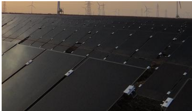
罗马尼亚某公司 45MW 光伏电站项目
