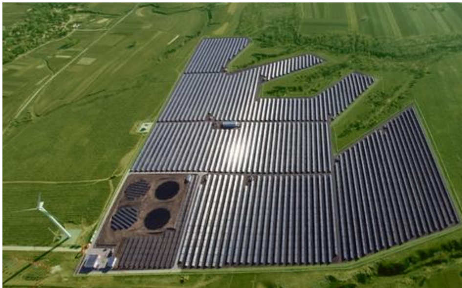
罗马尼亚某公司 45MW 光伏电站项目
