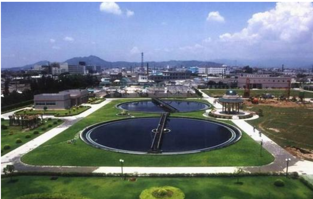
安徽省某景区污水处理厂及配套管网建设项目
