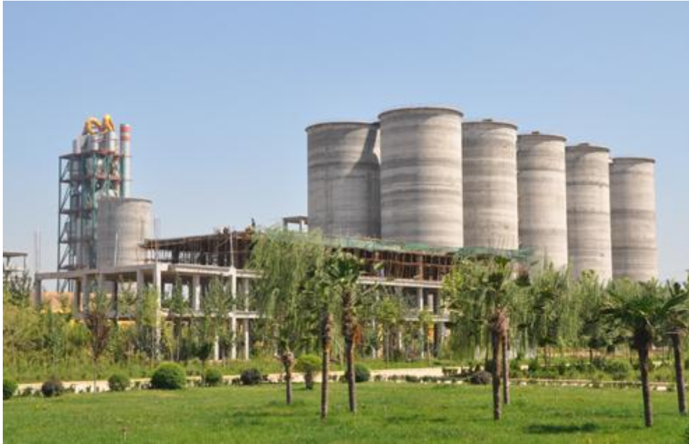
湖北省 60 万吨水泥改扩建项目
