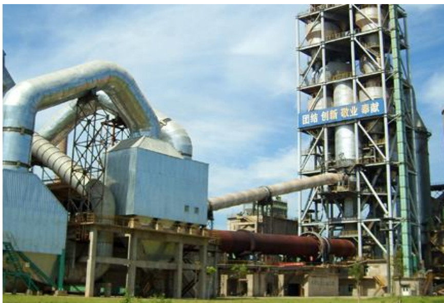
山西省某公司清洁型热回收捣固式机焦炉余热综合利用发电项目
