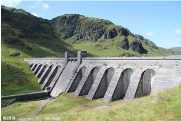
山西省水坝项目
