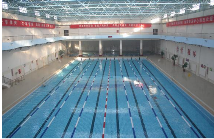
江苏某游泳馆项目
