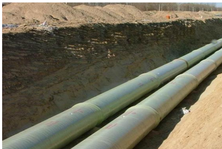
辽宁省排水管道项目
