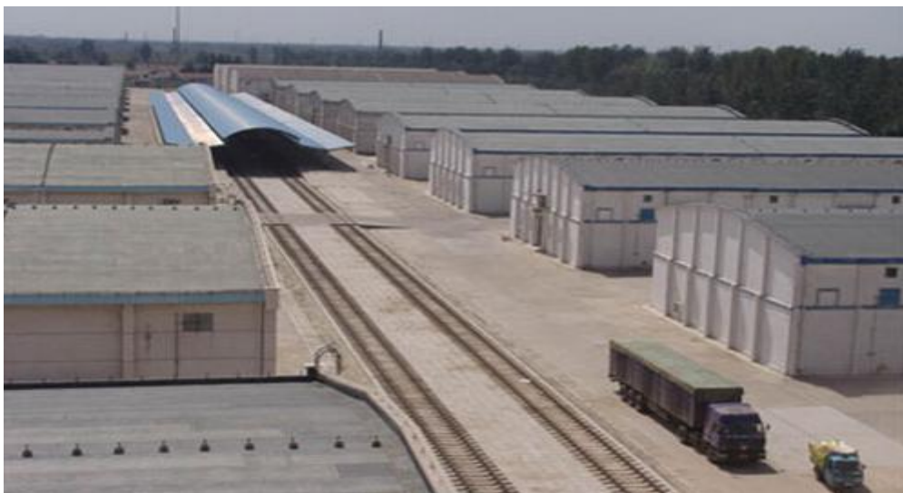
河南省 4.6 万吨储备粮散装平房仓项目
