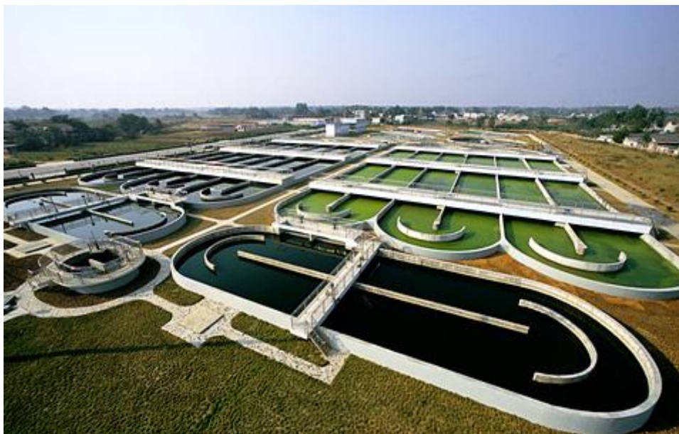
河南污水处理工程项目
